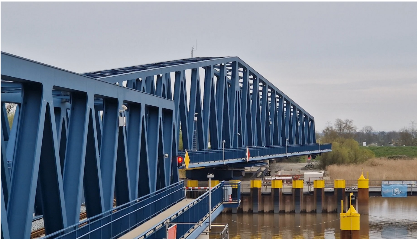
Bild 1: Der Neubau der Friesenbrücke als Hub-Dreh-Brücke
